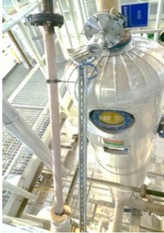
2. kép: Gőz cső melyre az ultrahangos szenzort installáljuk
